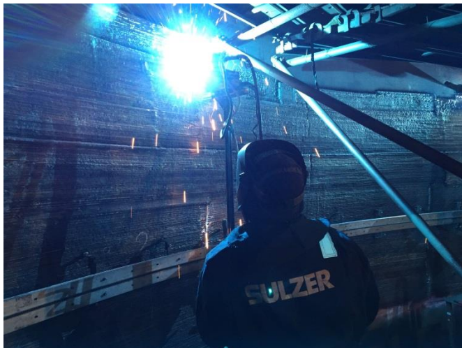
Bild 1: Koksöfenreparatur vor Ort
