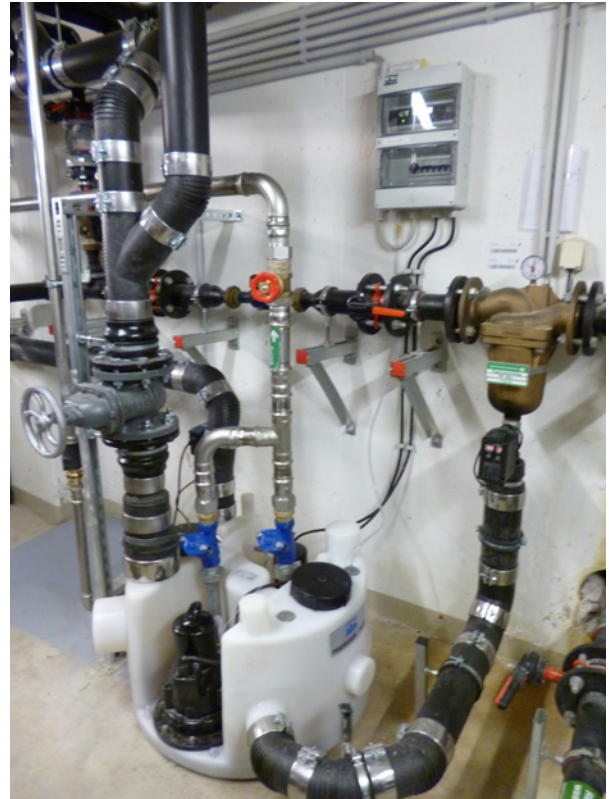
Piranhamat 1002 D, 25 m tief unter der „Erde“
