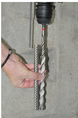
Fig. 5a Régler la profondeur de perçage
