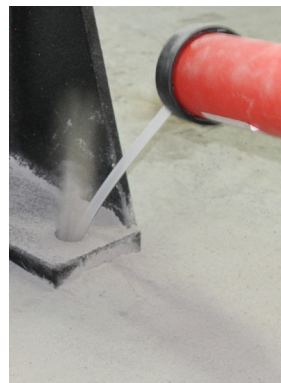
Fig. 8c Souffler l'alésage
