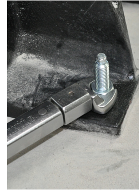
Fig. 9d Serrer l'écrou
