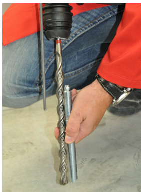
Fig. 8b Régler la profondeur de perçage
