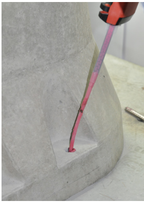
Fig. 6a Remplir de mortier
