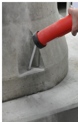
Fig. 5c Souffler l'alésage
