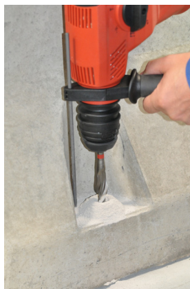
Fig. 5b Percer les alésages de fixation
